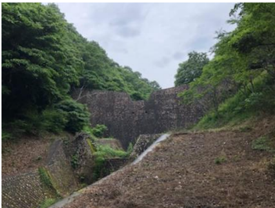
鯨川砂防ダム
