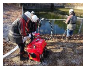
ポンプの運転
