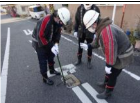
消火栓の点検
