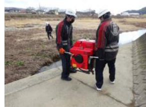
水源確保、ポンプ設置
