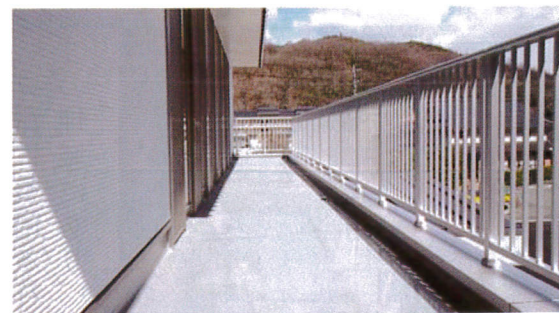
利用者の安全を考え設けたバルコニー
